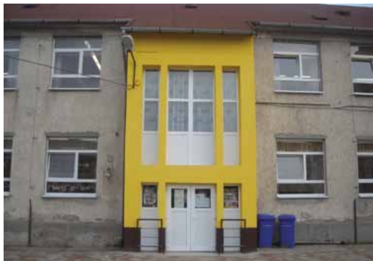
Az iskola épülete, új műanyag nyílászárókkal
