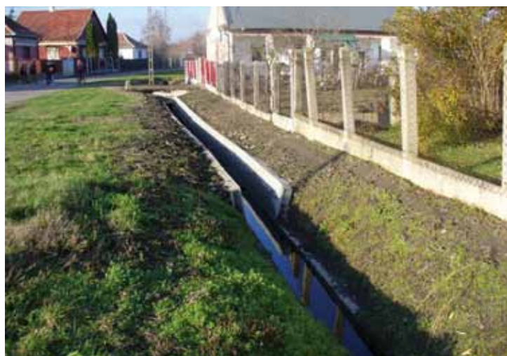
Árok megerősítése a Bocskai utcán
